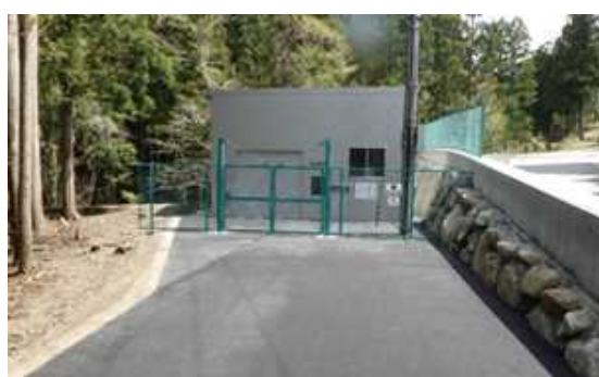
奥伊吹発電所
