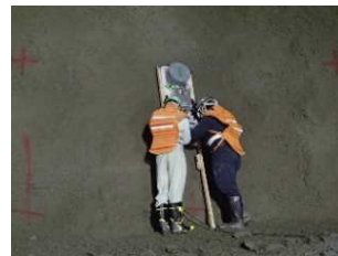
FDEMによるトンネル切羽前方探査
