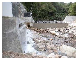
小水力発電所の建設
