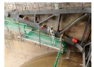
洪水吐ゲート点検
